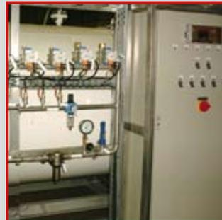
Steuerung einer Inertierungsanlage für eine Kohlenmahlanlage in Peru
