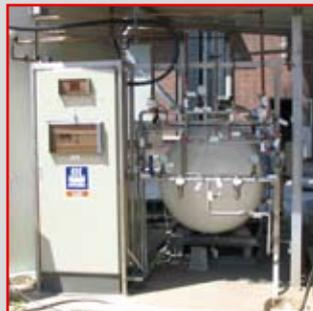
Inertgasanlage mit integrierter CO Messung
