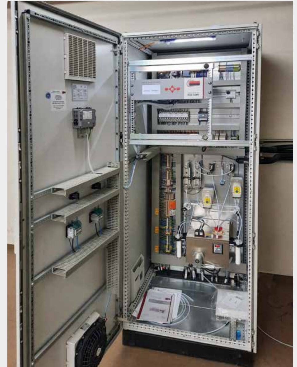
Bild 3 Das System besteht aus einer Monitoring-/Controleinheit und der Inertisierung. Quelle: robecca
