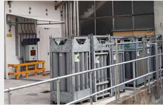
Bild 6 Die Inertisierungsanlage bestehend aus sechs Stickstoff-Bündeln und der Ventilstation INERT compact Quelle: robecco
