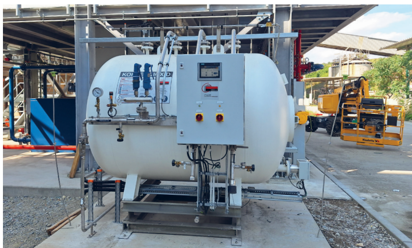
Bild 1: CO 2 -Bevorratung im Tank
